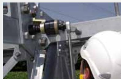
**alkitronic® M** en caso de trabajos de montaje en postes de corriente eléctrica, apriete preciso con una llave dinamométrica.
